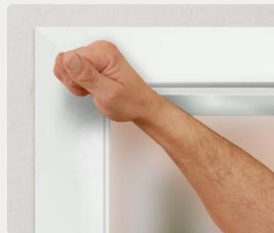
Nach dem Anpassen der Fußleiste an die neue Zargenbekleidung wird die Zarge einfach in die Maueröffnung gestellt, ausgerichtet und mit Türspreizen fixiert. Mit speziellem Montageschaum wird der fachgerechte Einbau der neuen Zarge fortgesetzt. Nach dem Aushärten des Montageschaums wird die Zierbekleidung aufgesteckt, das neue Türblatt eingehängt und der Türdrücker aufgeschraubt – fertig!
