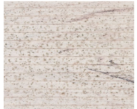
Stockflecken/Schimmel auf der Oberfläche
