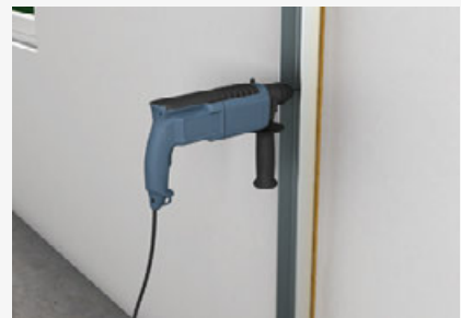
Befestigung der CW-Profile an Massiwand auf Dämmstreifen
