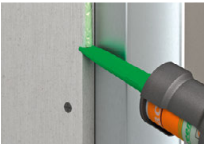
Führen der 310-ml-Kartusche an der Plattenkante. Die spezielle Kleberspitze sorgt für die exakte Klebermenge bei 10- und 12,5-mm-Platten. Bei 15- und 18-mm-Platten muss die Spitze angeschnitten werden
