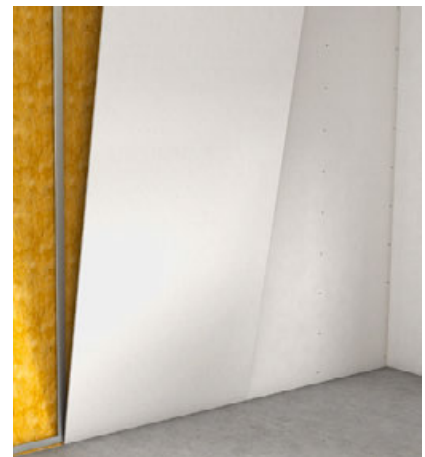
Bekleidung der Metallunterkonstruktion
