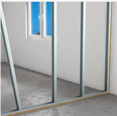
Montage der CW-Ständerprofile
