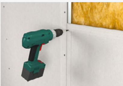
Schrauben auf Stahlunterkonstruktion
