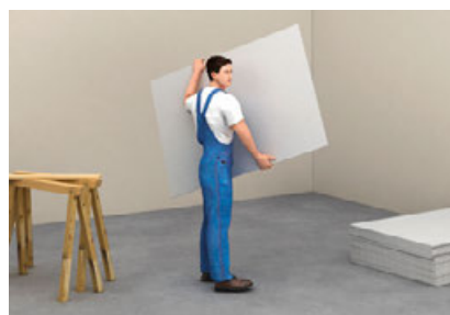
Einzelne fermacell® Gipsfaser-Platten hochkant tragen
