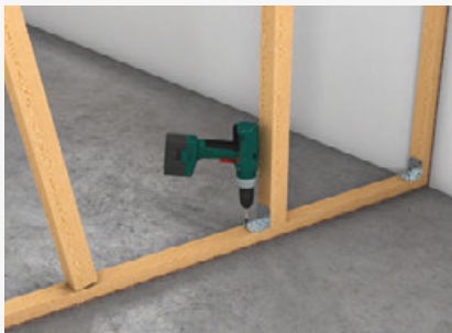
Montage der Holzständer mit Stiftnagel oder Stahlwinkel
