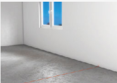
Anlegen der Wandachse mit Schnurschlag oder Hochbaulaser
