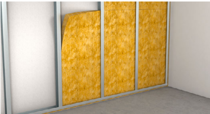
Einbringen der Dämmstoff-Platten
