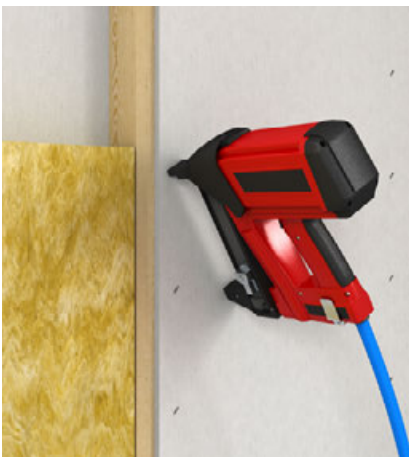
Bekleidung der Holzunterkonstruktion mit Klammern
