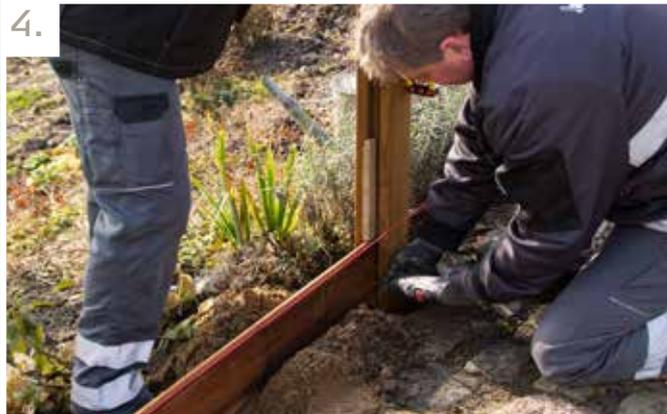
Platzieren Sie den nächsten Pfosten. Verwenden Sie ein Zaun-Profil um den genauen Abstand einzuhalten. Heben Sie ein neues Loch aus und platzieren Sie den nächsten Pfosten auf die gleiche Weise wie in Punkt 2. Schrauben Sie das obere und untere Profil mit einer temporären Schraube fest.
