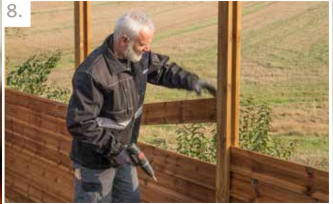
8. Montieren Sie den Rest der Profile. Die unteren und oberen Profile müssen mit zwei Schrauben an jedem Ende befestigt werden, während die mittleren Profile mit einer Schraube an jedem Ende befestigt werden. Nasse Profile sollten eng aneinander befestigt werden, während trockene Profile mit 2-3 mm Luft zwischen Feder und Nut befestigt werden sollten, damit diese sich ausdehnen können.
