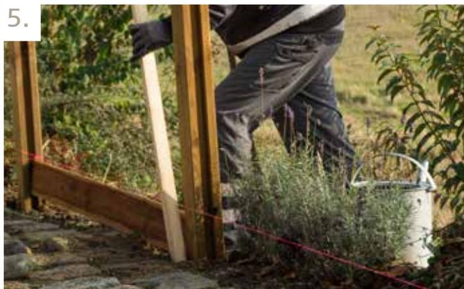
Jetzt haben Sie die Entfernung vom ersten zum zweiten Pfosten, stampfen Sie die Erde drumherum fest. Kontrollieren Sie regelmäßig an Hand einer Wasserwaage dass die Pfosten gerade platziert werden.
