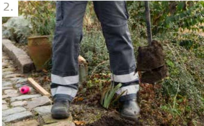
Finden Sie zuerst heraus wo der erste Pfosten platziert werden soll, damit der Pfosten stabil steht, bohren oder graben Sie das erste Loch 80 bis 90 cm tief. Stellen Sie sicher das der Pfosten gerade steht, bevor Sie das Loch mit Erde füllen (falls erforderlich den Pfosten in Beton gießen).
