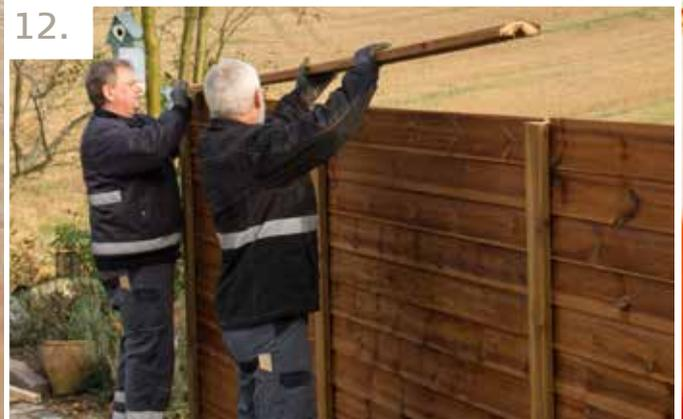
12. Jetzt fehlt nur noch die Montage des Abschlussprofils. Am schönsten sieht es aus, wenn das Profil 1-2 cm über die Enden ragt. Markieren Sie die Mitte des Pfostens, dort wo das Abschlussprofil gesägt werden soll. Das Abschlussprofil wird mit zwei Schrauben an jedem Pfosten montiert. Wenn Sie die Spalten der Profile vermeiden möchten, ist es eine gute Idee Löcher für die Schrauben vorzubohren.
