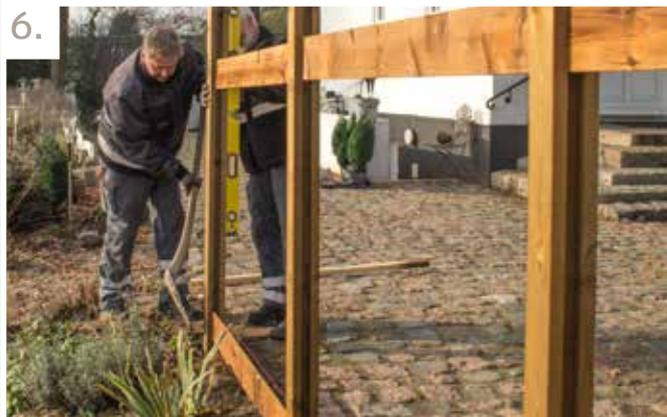
Um alles zusammen zu halten, platzieren Sie die restlichen Pfosten mit dem oberen und unteren Profil auf die gleiche Weise wie zuvor beschrieben, bis alle Pfosten auf ihrem Platz stehen, zum Schluss können Sie die mittleren Profile montieren.
