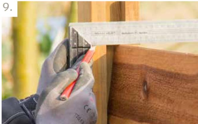
9. Wenn alle Profile platziert sind, werden die Pfosten in der richtigen Höhe gekürzt. Markieren Sie die Pfosten an der Spitze mit einem Winkel, entfernen Sie das oberste Profil, nun die Pfosten unterhalb der Oberkante des oberen Profils auf 1,5 cm schneiden.
