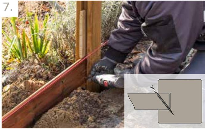
7. Nun können Sie das erste Profil fest verschrauben, beginnen Sie an der Unterseite des Zaunes. Verwenden Sie eine 4,0 x 60 mm. Schraube, es sollten mindestens 4 cm zwischen Profil und Erde eingehalten werden. Alle Profile werden mit einer Schraube an jedem Ende befestigt.
