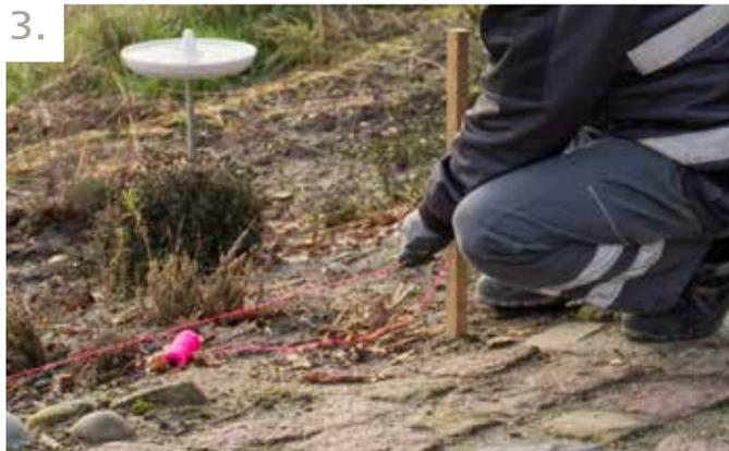
Wenn der erste Pfosten platziert ist, platzieren sie einen Stab in der Flucht mit dem Zaun und ziehen Sie eine Schnur vom ersten Pfosten zum Stab, um somit sicherzustellen dass die darauffolgenden Pfosten in einer geraden Reihe platziert werden.
