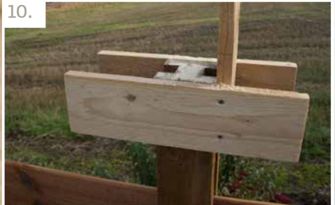
10. Als Hilfe können Sie sich eine Schneidelade aus drei Holzstücken mit einer Kante zusammenschrauben in der Sie die Säge führen können. Wenn alle Pfosten zurecht gesägt sind, setzen Sie das letzte Zaun-Profil ein und schrauben Sie es fest. Denken Sie daran, dass die oberen Profile zwei Schrauben an jedem Ende benötigen.
