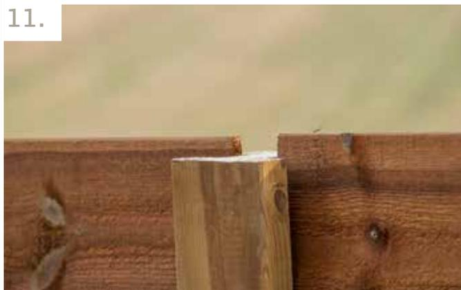
11. Um ein Verschieben des Abschlussprofils nach oben zu vermeiden, müssen mindestens 5 mm Abstand zwischen der Spitze des oberen Profils und dem Abschlussprofil eingehalten werden.
