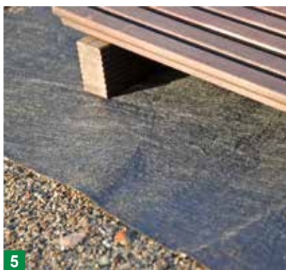
5 Wasserdurchlässiges Abdeckvlies gegen Durchwurzelung u. Pfützenbildung.
