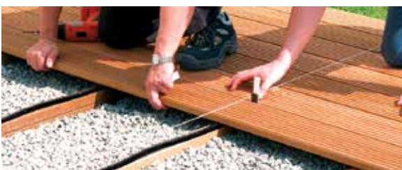
Lehre für gleiche Fugenabstände
