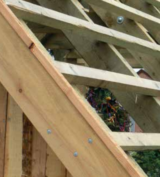
Lärche – Dachstuhl im Detail
