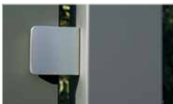
Detail-Ansicht zwischen Pfosten und Fassadenplatte HPL
